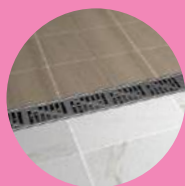
รางระบายน้ำ แบบระบายพื้น
